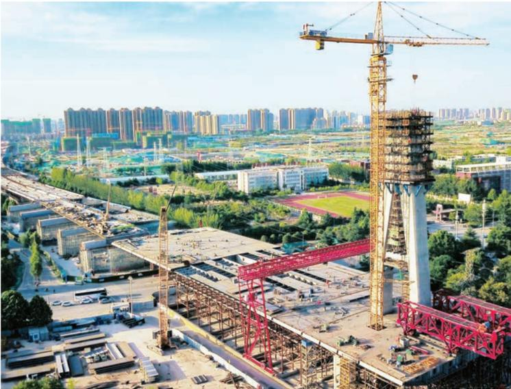
由一公司承建的大河路快速化工程第六标段,截至目前,已累计完成工程量如下:主线承台累计完成160座,占比96.7%;主线墩柱累计完成228根,占比91.57%;4、零号块:主线已完成65个,占比53.3%。另外,主线预制梁已完成架设170幅。现浇梁段共3联(分左右幅),其中64联及81联右半幅已浇筑完成,北半幅正处于钢筋绑扎及模板加固阶段,预计月底开始混凝土浇筑工作。
